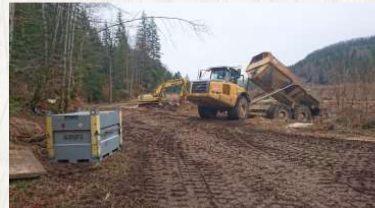
Comblement du lit rectiligne
